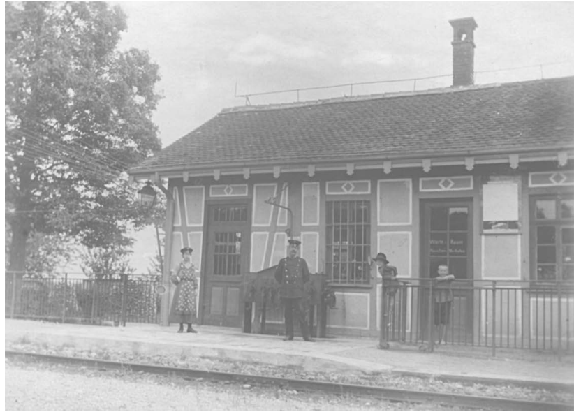
Vor dem Fahrdienstgebäude und Warteraum des Bahnhofs Hochberg bei Saugau, 1916/1917. Von links nach rechts: Maria, Vater Johann Ruf, Johannes, Josef.
